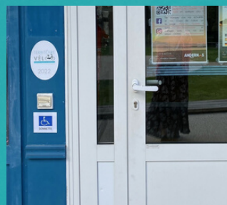
UNE SONNETTE AU NIVEAU DE LA PORTE D'ENTRÉE
