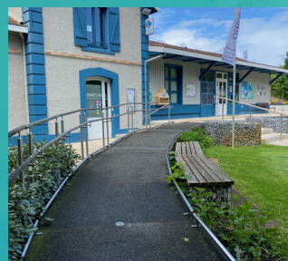
UNE RAMPE D'ACCÈS AVEC BORDURE CHASSE ROUE
